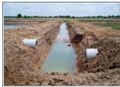
การวางท่อระบายน้ำบริเวณทางลำเลียงน้ำ
