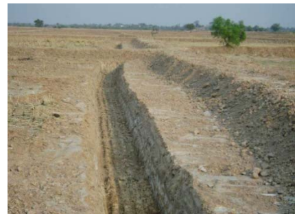
การขุดร่องน้ำรองรับน้ำเค็ม
